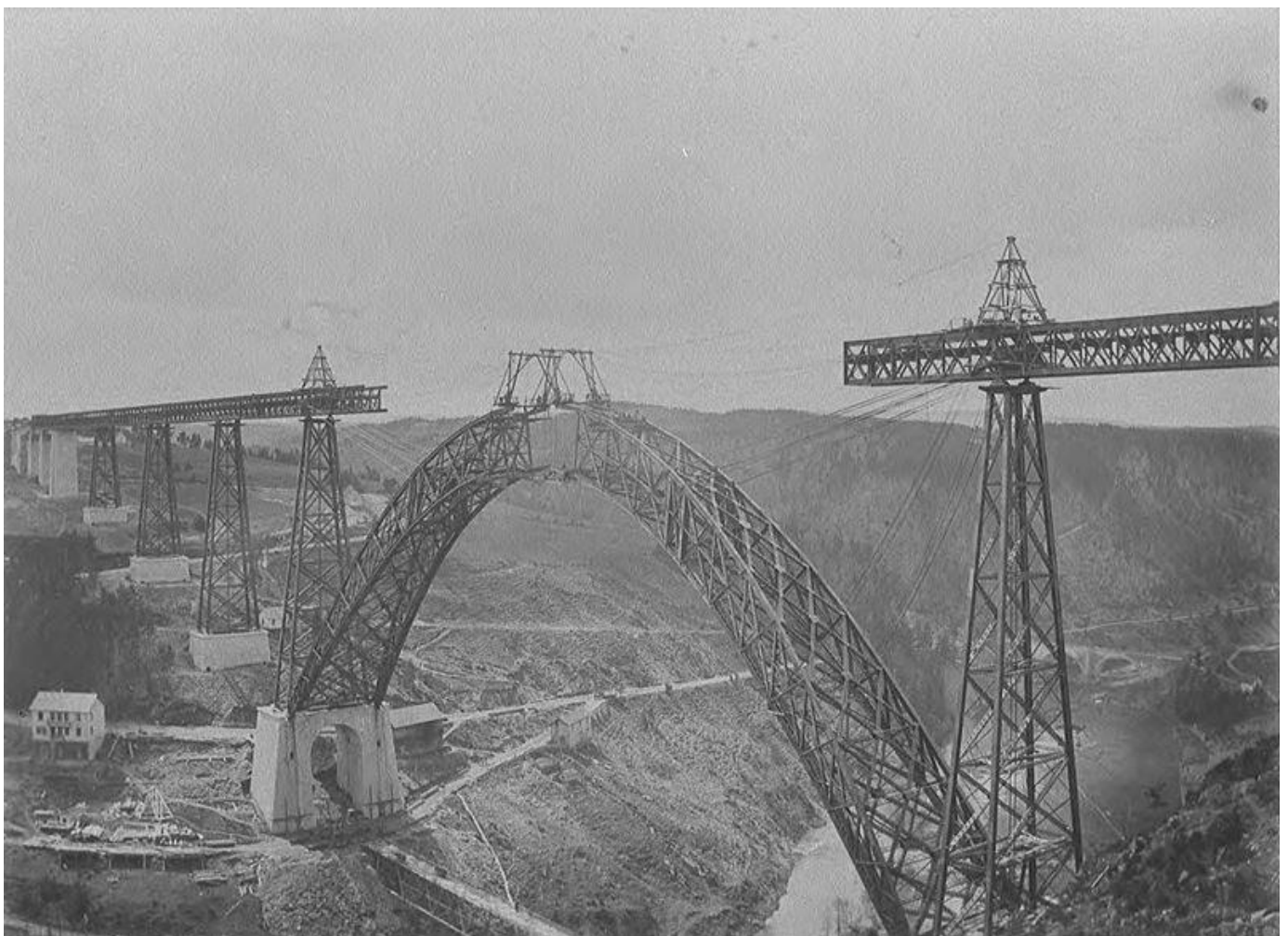
Viaduc de Garabit, construction en encorbellement de l'arc.
