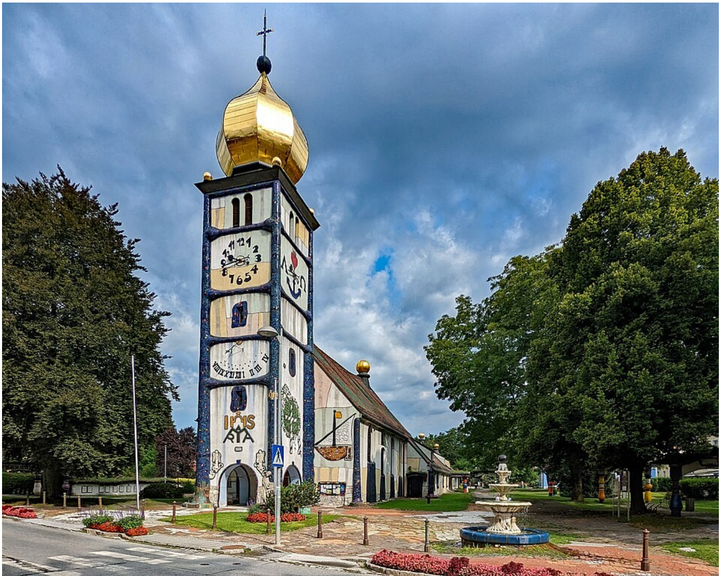
Église de Bärnbach en Autriche - Wikipédia
