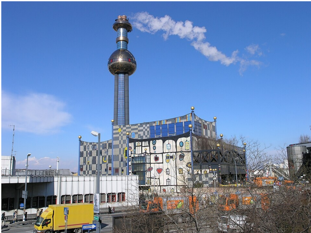
Incinérateur à Vienne – Autriche - Wikipédia
