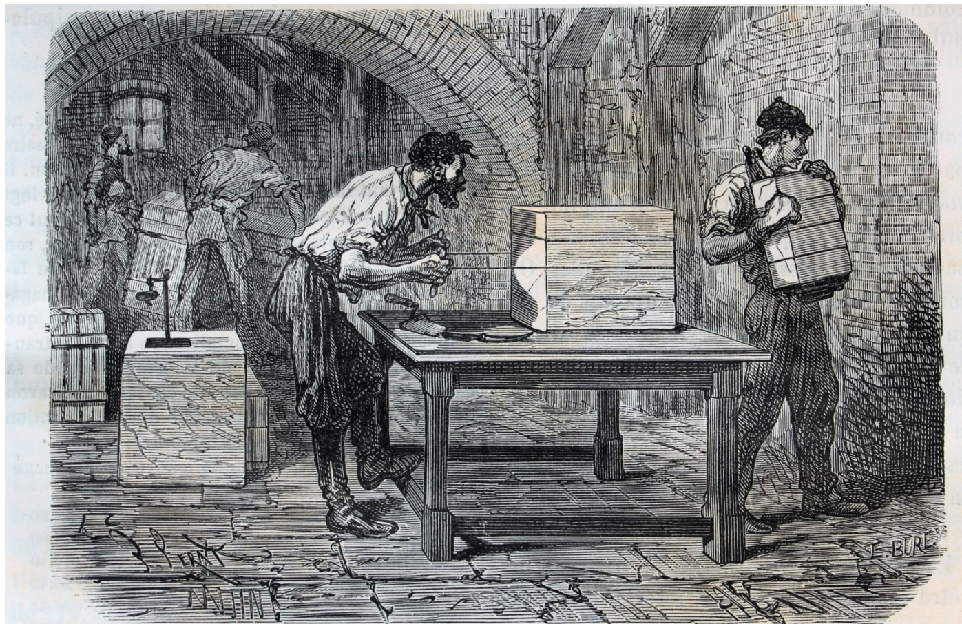
Fig. 296. — Coupe d'un pain de savon de Marseille en barres, au moyen d'un fil de fer.
