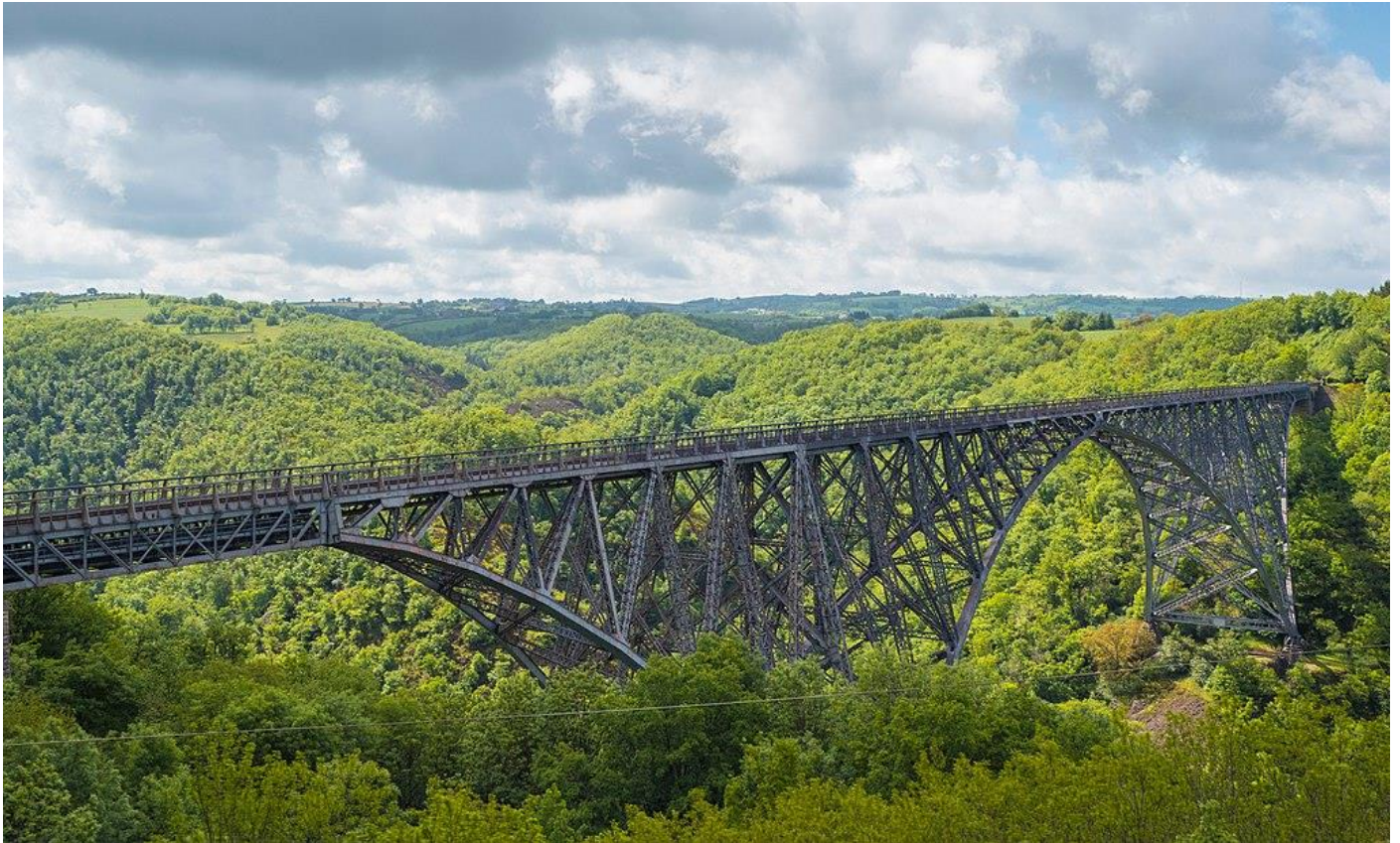
Viaduc du Viar (Aveyron)
