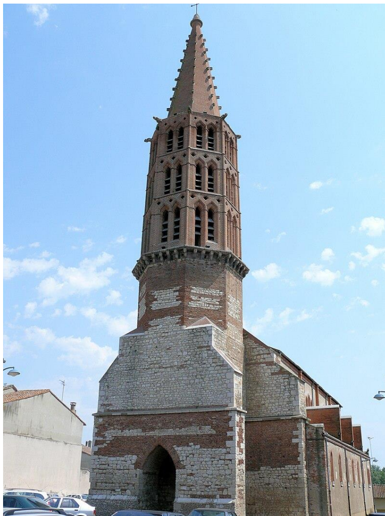
Église Saint-Pierre-ès-Liens de Nègrepelisse (Tarn-et-Garonne) reconstruite par l'architecte Jules Bourdais
