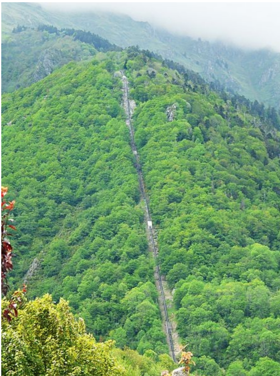
Conduite forcée à Guchan Htes Pyrénées source Wikipedia
