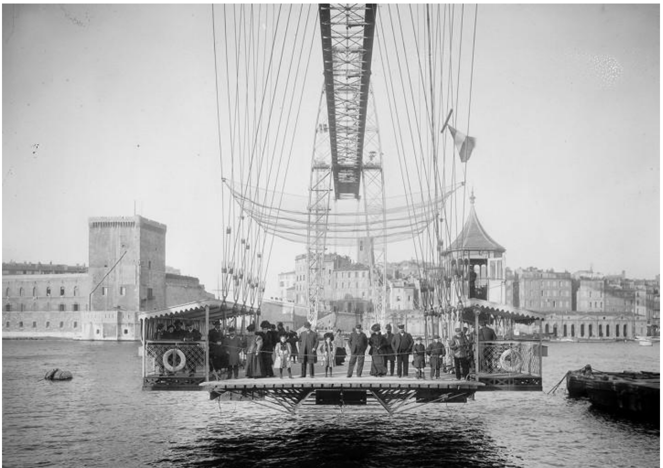
Nacelle du pont transbordeur du Vieux-port à Marseille - à l'époque, il est la « Tour Eiffel » de Marseille
